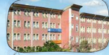
Okulumuzun Ön Cephesi
